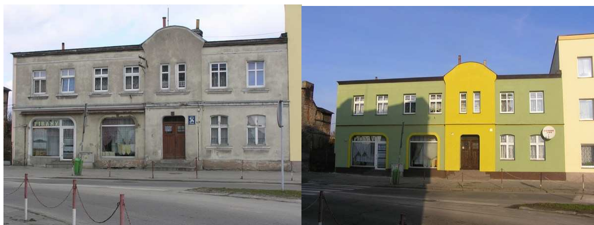
Kamienica przy ul. Chojnickiej 34 przed i po pracach remontowych (fot. PUP)
